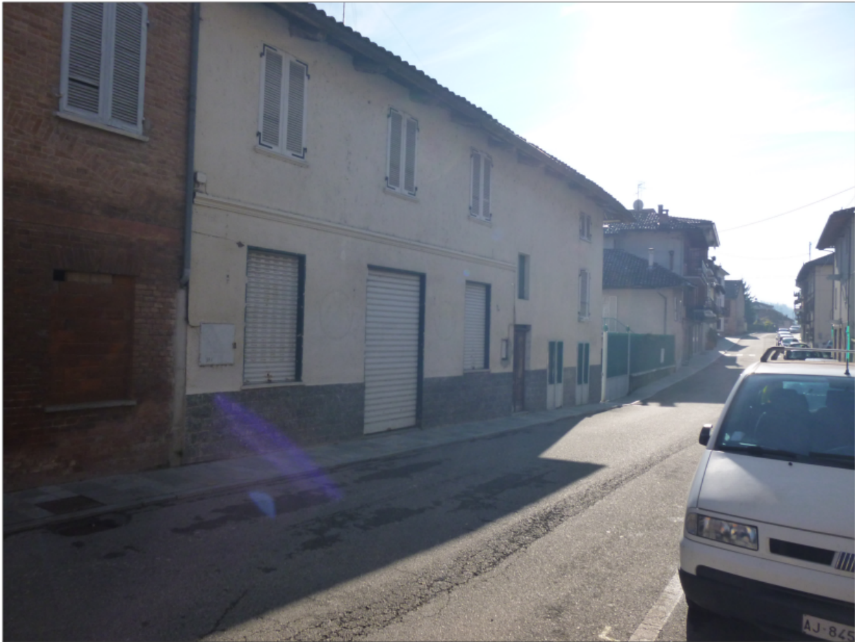
VISTA_1 PROSPETTO OVEST SITUAZIONE IN STATO DI FATTO
