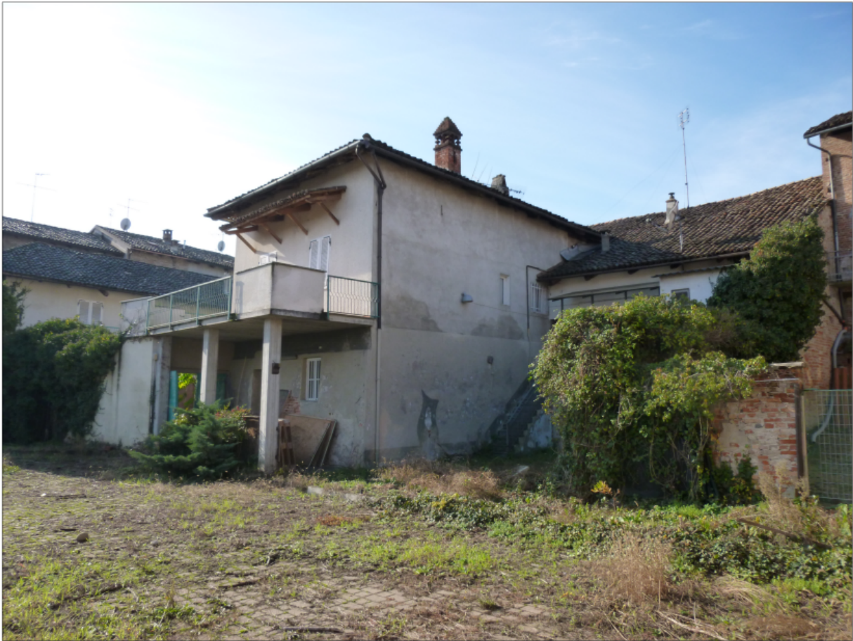
VISTA_5 PROSPETTI NORD-EST SITUAZIONE IN STATO DI FATTO
